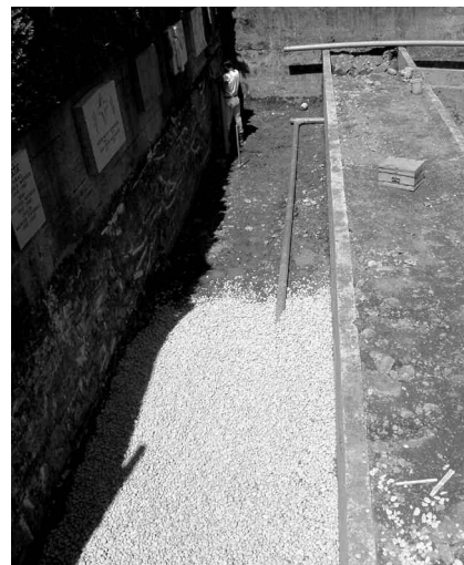
Die Sickerrohre werden eingelegt und mit Sickerkies zugedeckt
