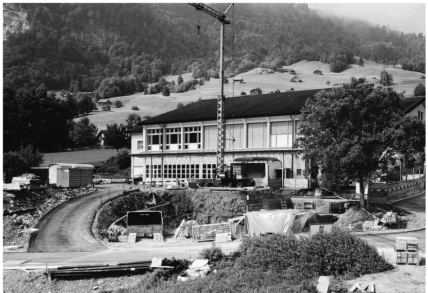
Bauarbeiten Holzschnittelheizung Steini
