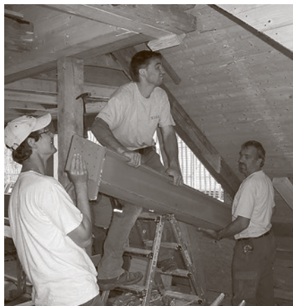
Adrian Murer, Willi Odermatt und ein weiterer Mitarbeiter beim Montieren eines Stahlträgers
