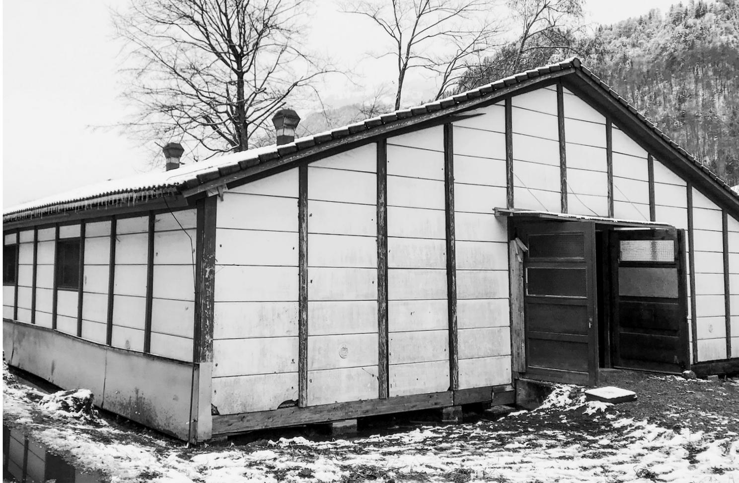
Der Balken am Boden wurde ersetzt, damit die Stabilität gewährleistet ist
