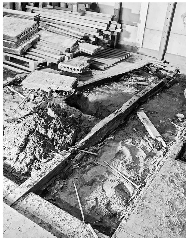
Der getrocknete Schlamm unter dem Fussboden wird nicht ausgepackt, da er die Bodenkonstruktion zusammenhält
