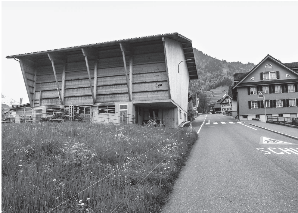
Mit dem grösseren Abstand des Neubau zur Wiesenbergstrasse wurden im Jahr 2018 die Sichtweiten beim Fussgängerstreifen stark verbessert
