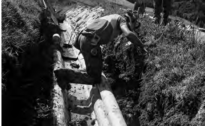
Einbau von Trapezkännel im Ufgänderkrättlig
