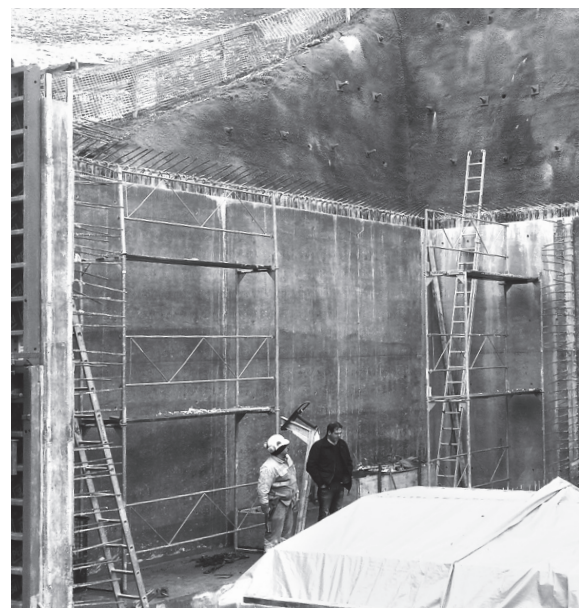
Die Dimensionen sind im Rohbau gut ersichtlich
